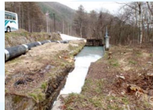
沈砂池を大型化して、砂が下流に
